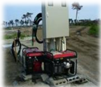
可搬型発電機
