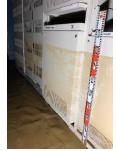
坂本ビル内の浸水 (約80cm)
