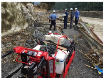
可搬型基地局等の資材の運搬 (写真提供:KDDI株)
