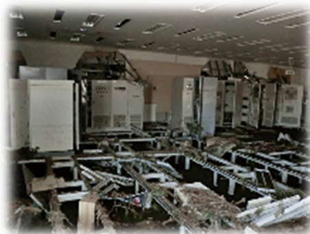
津波により被災した海底ケーブル陸揚局 (写真：KDDI)
