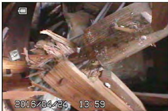
支柱の破壊
