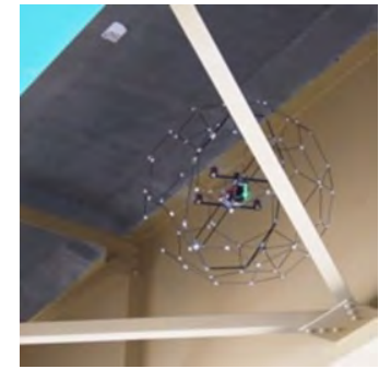
(b) 橋梁点検球殻ドローン (国交省実証試験)
