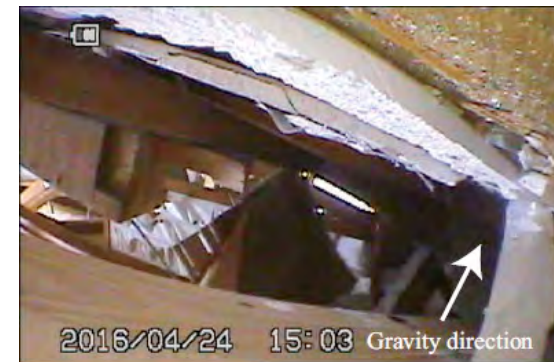
床材の破壊
