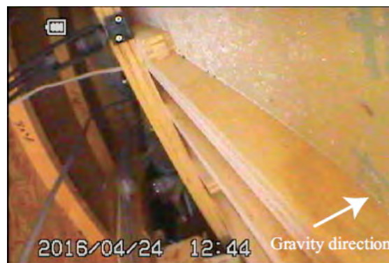
屋根裏の状況
